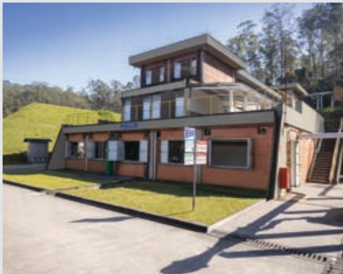
Fábrica de Pólvora CBC Ribeirão Pires - SP
